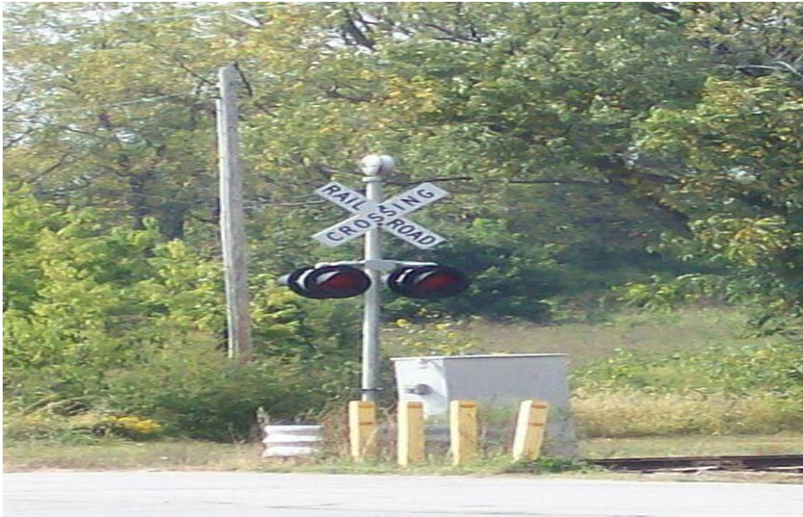
Resim 1.19: Otomatik flaşıörlü bariyerli hemzemin geit
