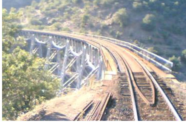
Resim 1.4: Köprülerde kontray uygulaması
