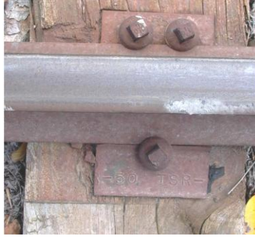
Resim 2.3: Ahşap traversli “N” tipi bağlantı şekli
