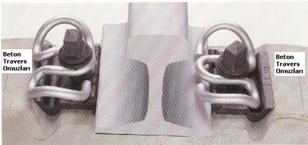
Resim 2.6: “HM” tipi bağlantı şekli
