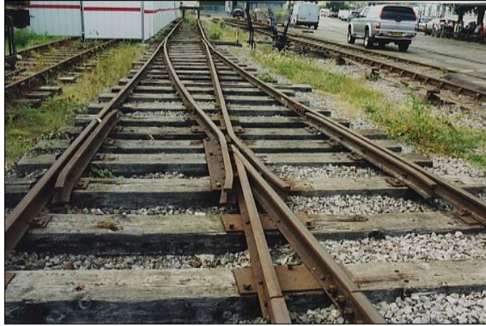
Resim 1.3: Makaslarda birleşik ray uygulaması
