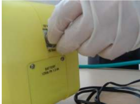
Resim 4.3: Ventilatörle elektrik bağlantısını yapma
