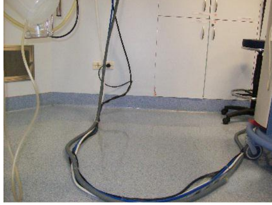
Resim 1.15: Anestezi cihazı atık gaz hortumları
