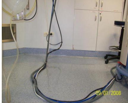
Resim 4.5: Anestezi cihazı atık gaz hortumları
