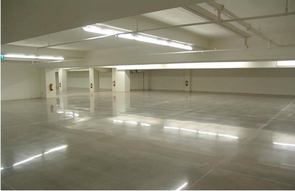
Fotoğraf 1.7: Beton zemin
