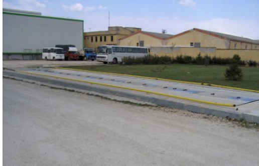
Fotoğraf 2.1: İşletme girişinde kamyon kantarı
