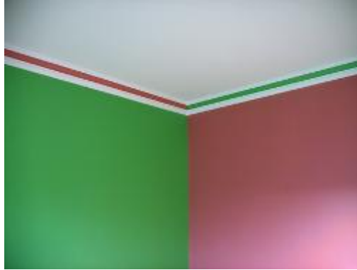
Resim 1.86: Saten boya uygulaması
