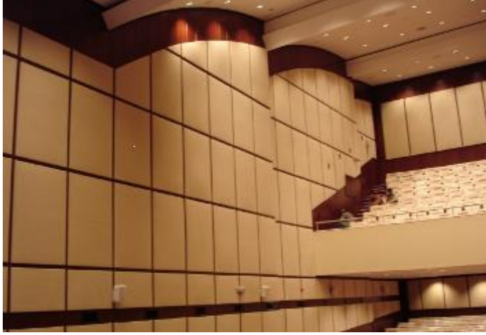
Resim 1.11: Akustik duvar kaplamaları
