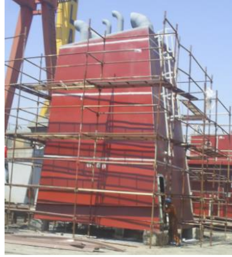
Resim 3.2 Tersanede baca inşası
