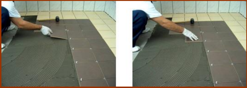
Resim 2.5: Seramik karonun el ile tespiti
