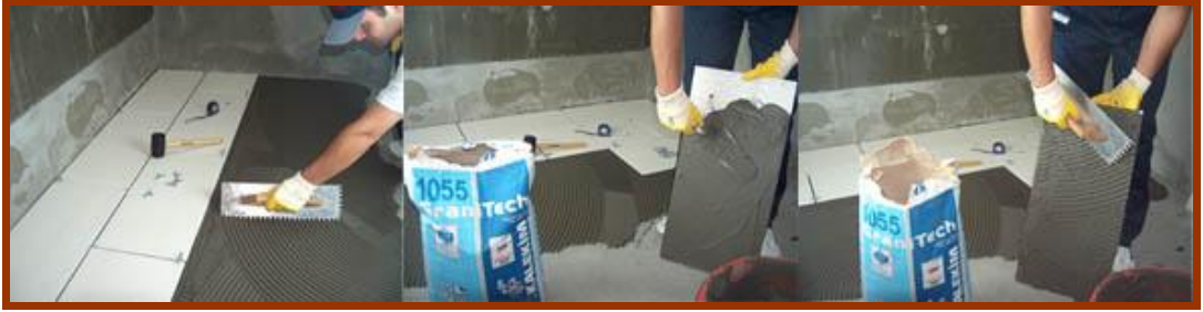
Resim 2.1: Taraklama, yağlama ve kombine yöntemleri
