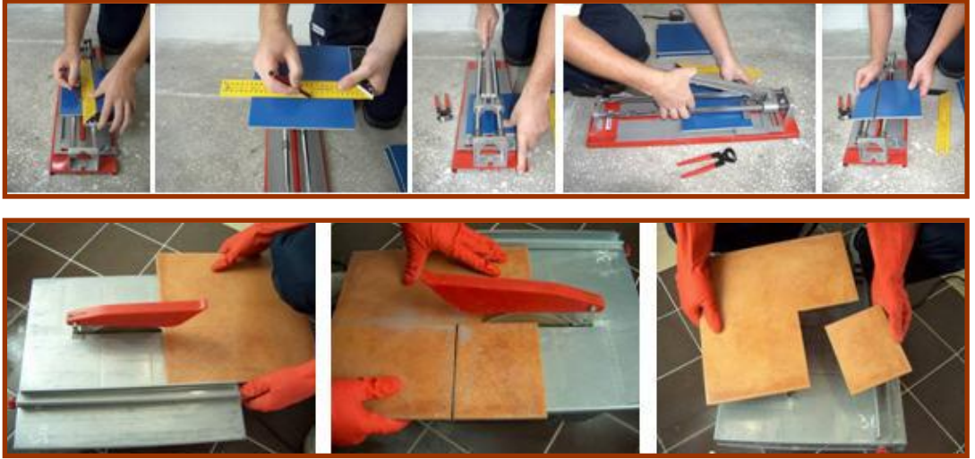
Resim 2.7: Seramik karonun el ve makine ile kesimi
