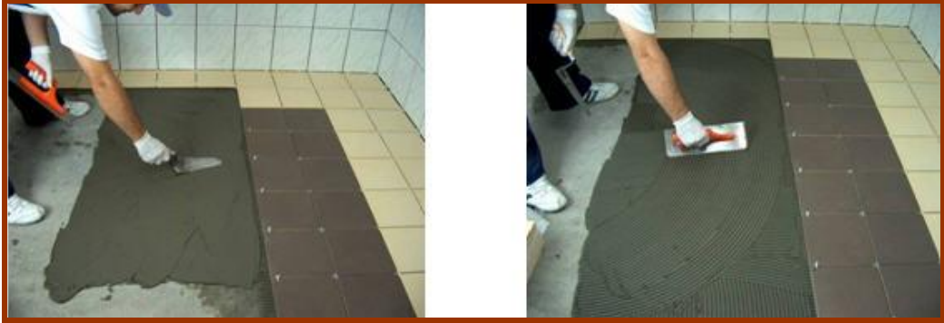
Resim 2.4: Yapıştırma harcının zemine yayılması ve taraklanması
