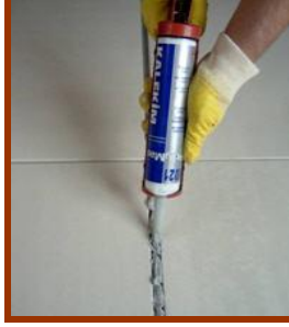
Resim 1.10: Poliüretan mastik dolgu malzemesi ile doldurma
