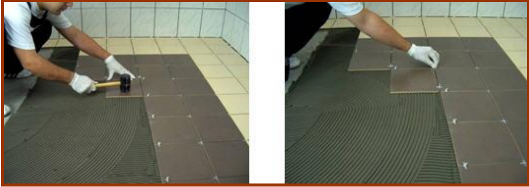
Resim 2.6: Seramik karoların tokmaklanması ve derz artılarının yerleştirilmesi
