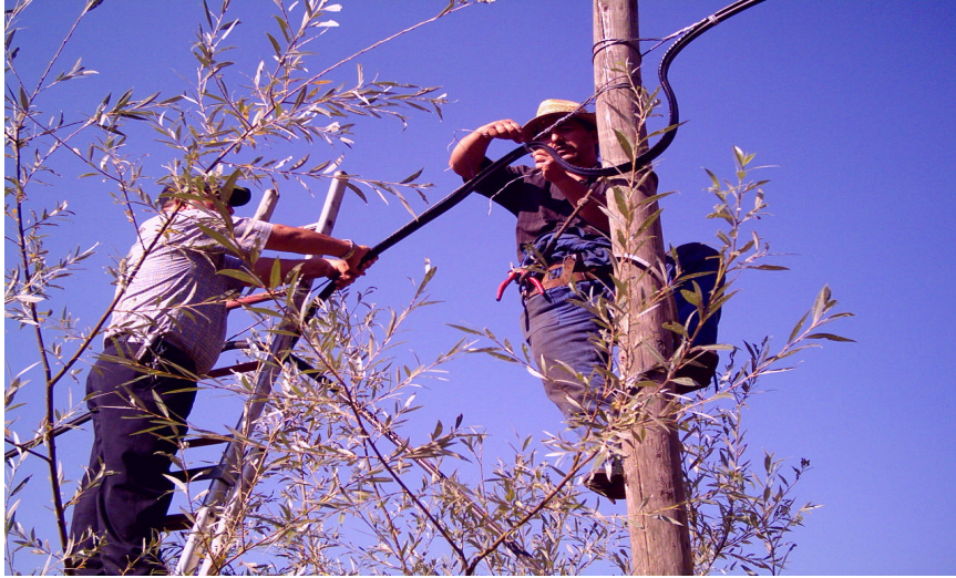
Resim 3.2: Yeni kablonun hatta baęlanması
