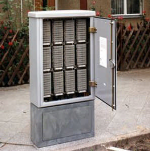
Resim 1.2: Saha dolabının içten görünümü
