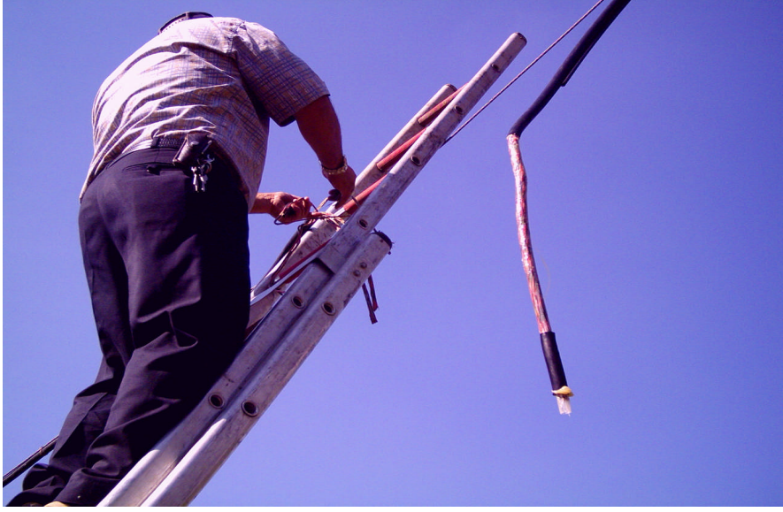
Resim 3.3: Yeni kablonun ek için hazırlanması
