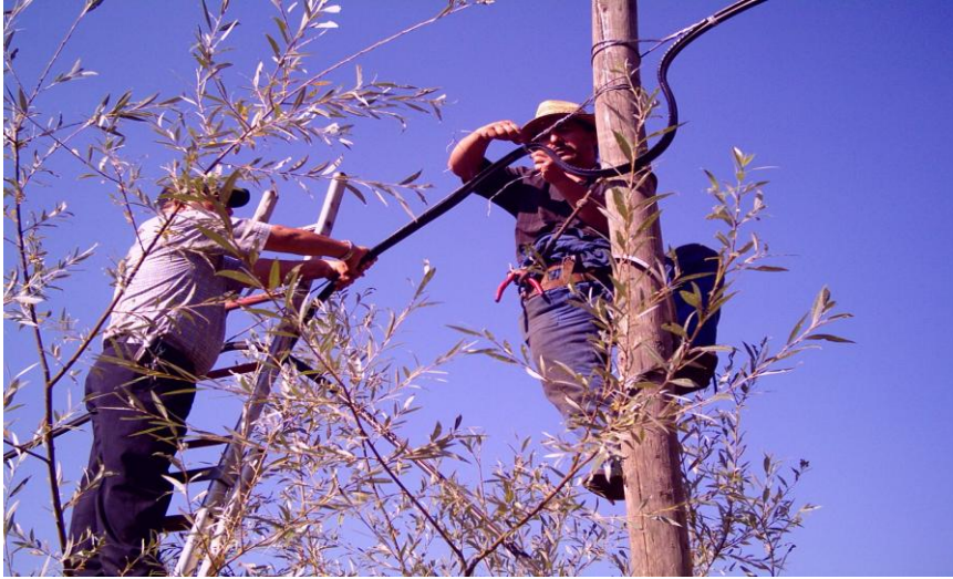
Resim 3.2: Yeni kablonun hatta baęlanması
