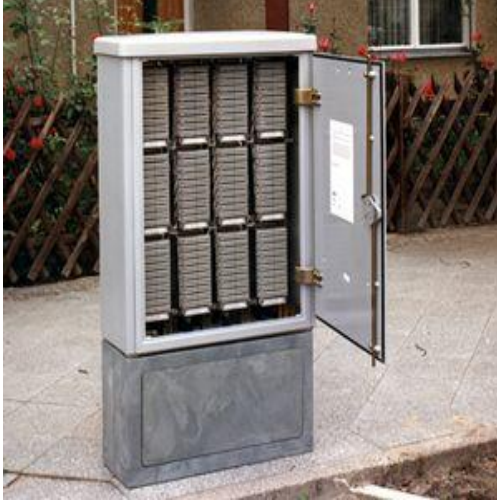
Resim 1.2: Saha dolabının içten görünümü
