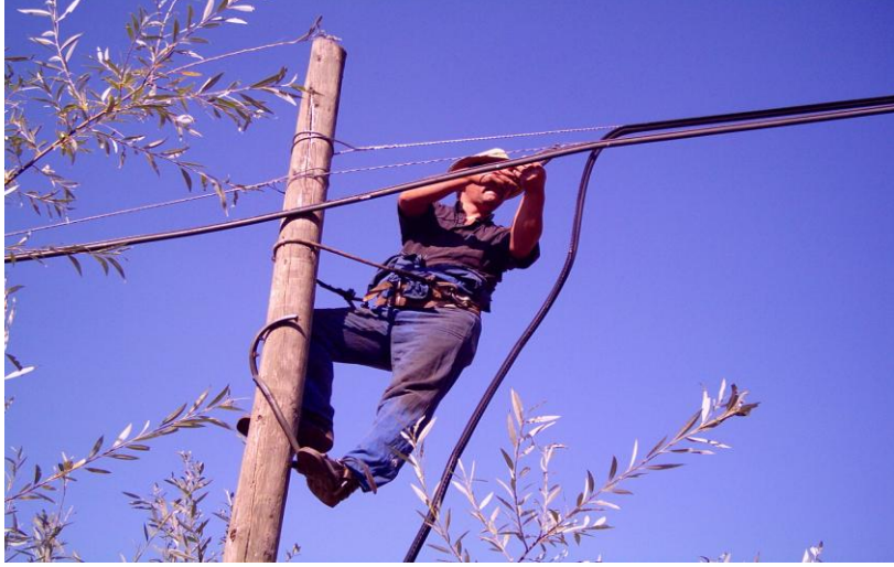
Resim 3.1: Arızalı kablo deęiřimi
