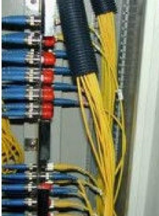
Şekil 3.46: Kaset bağlantısı PIGTAIL
