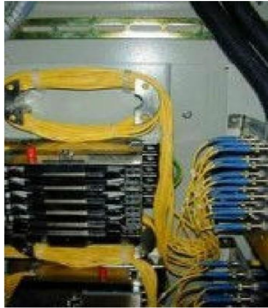
Şekil 3.44 Fiber optik lif kaseti
