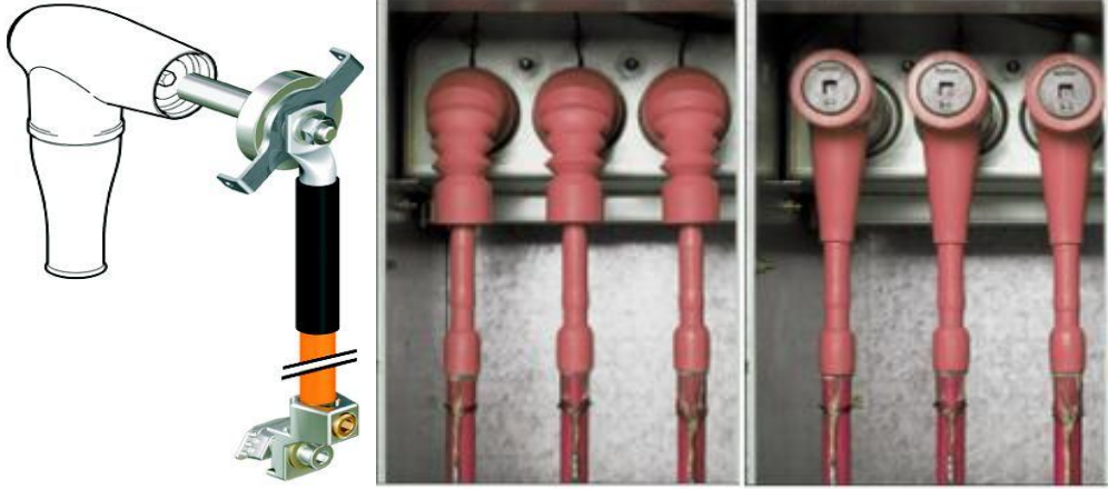
Resim 4.14: Konektör ile kablo bağlantısı yapımı
