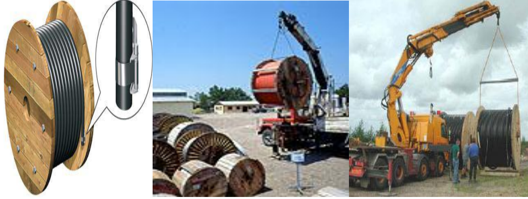
Resim 2.2: Kablo makarası ve indirilmesi
