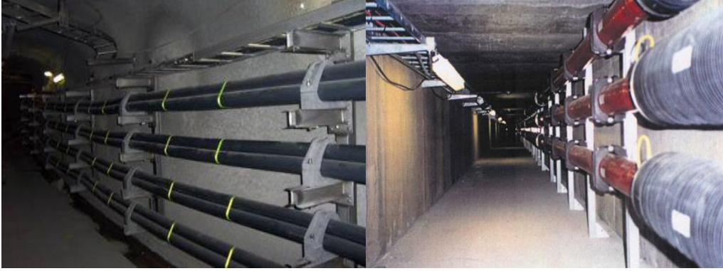
Resim 2.26: Kablonun kroşelerle ve kablo merdiveni ile duvardan döşenmesi
