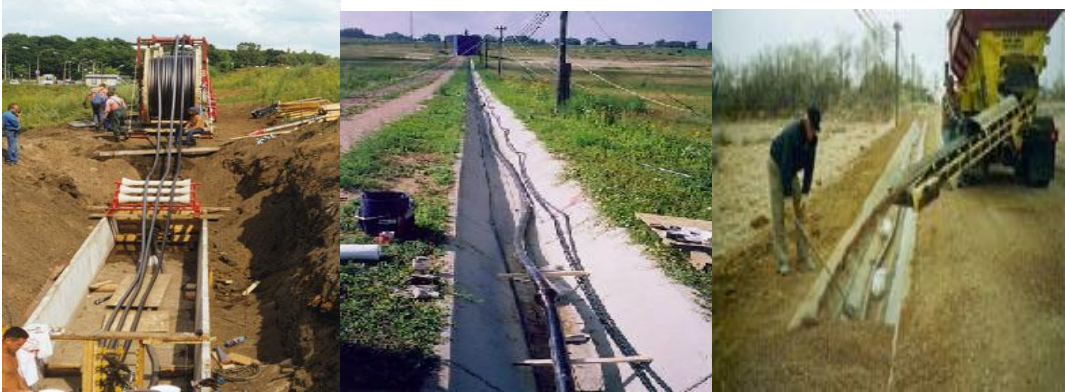
Resim 2.15: Kabloların beton kanallara dökmesi ve kanalın kapatılması
