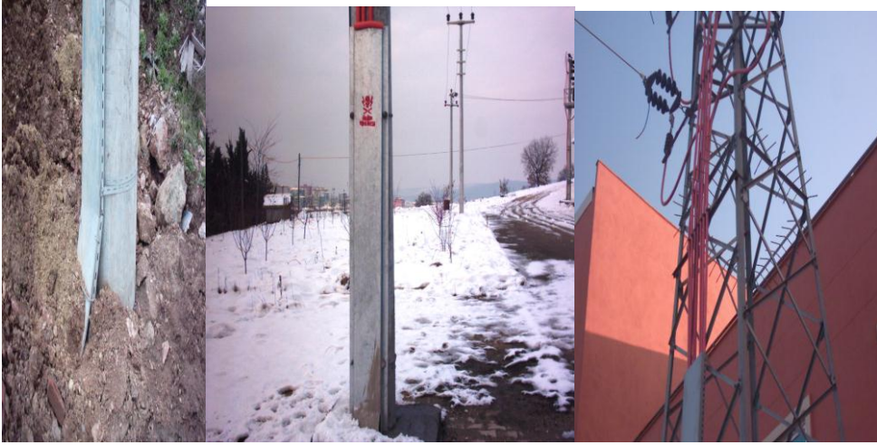
Resim 4.5: Direkte bağlantı yapılan kabloların sac kanal ile korunması
