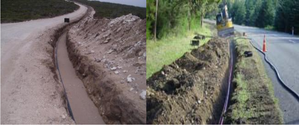
Resim 2.11: Kanala kum dşenmesi ve kablunun yerleştirilmesi
