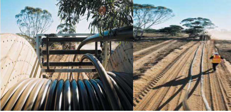
Resim 2.5: Kablonun serilmesi
