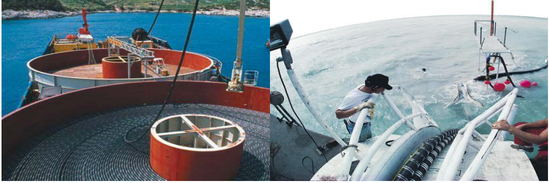
Resim 2.21 : Kablonun dşeme aracından denize indirilmesi
