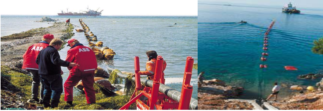
Resim 2.22: Kablonun denizden çekilmesi
