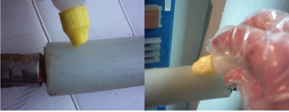
Resim 3.13: YE3SV kablo yalıtkanı üzerine başlığı takmadan önce silikon yağının sürülmesi
