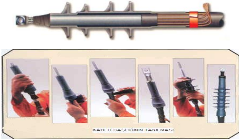
Şekil 3.8: Haricî tip tek damarlı kablo başlığının takılması
