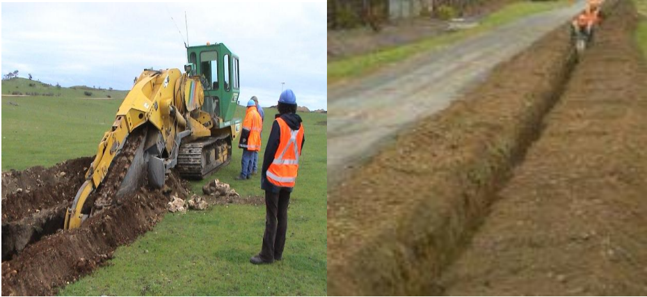
Resim 2.10: Toprak zeminde kablo kanalı açma
