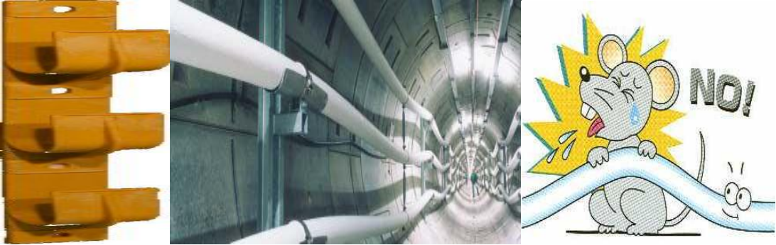
Resim 2.25: Kablo kelepçesi ve tünel geçiş kablosunun tutturulması
