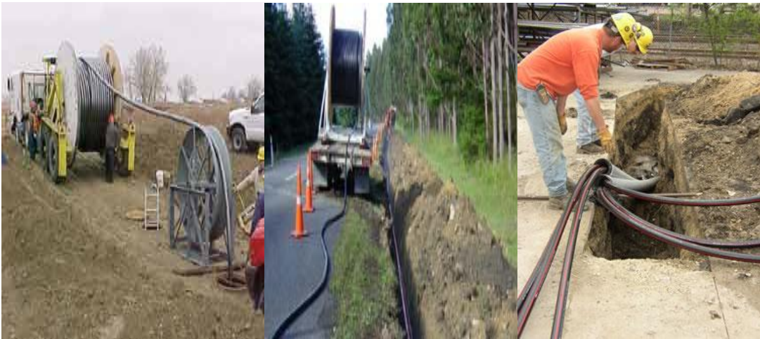
Resim 2.12: Kanala kablunun dşenmesi
