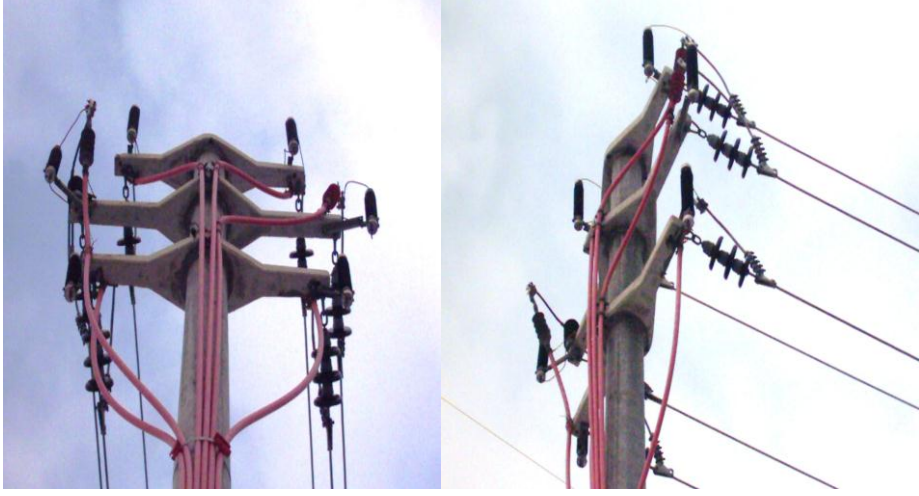
Resim 4.10: Başlıklı kabloların havai hatlara bağlantısı(parafudur korumalı)
