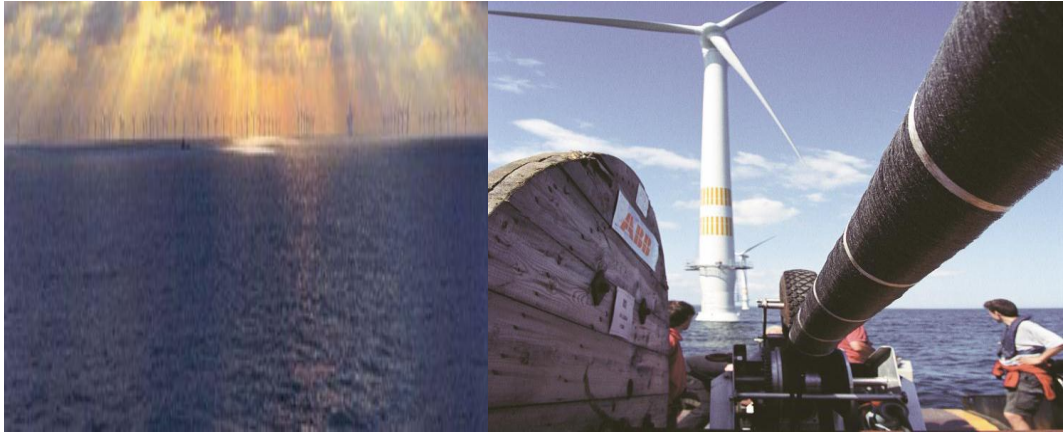
Resim 2.19: Denizde bulunan rüzgâr santrali ve kablo çekimi
