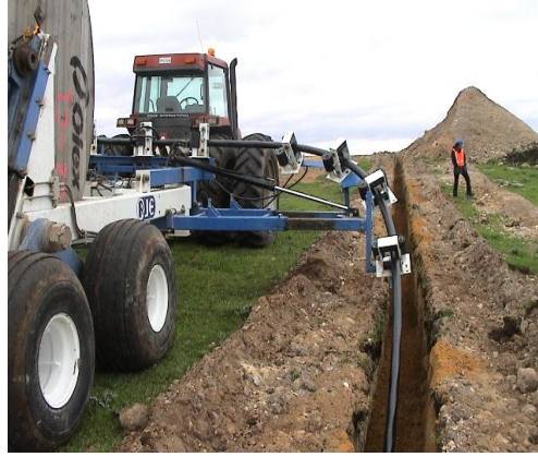
Resim 2.8: Kablonun serilmeden dösenmesi
