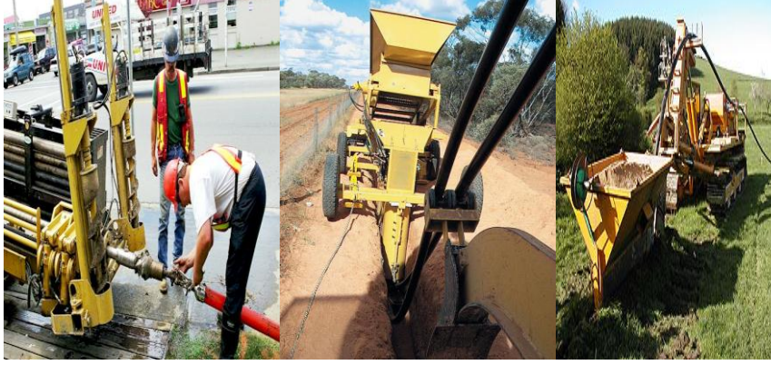
Resim 2.13: Kablonun çekme makinesine bağlanması ve dökmesi
