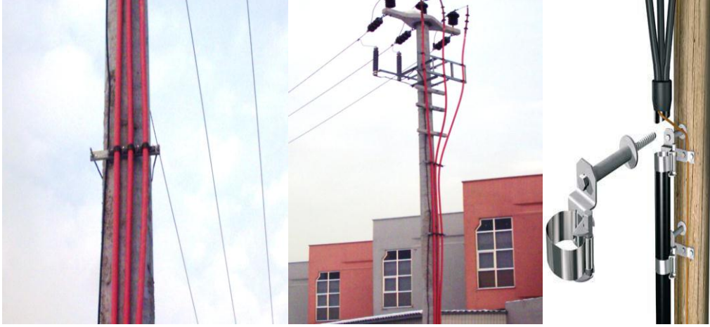
Resim 4.7: Yer altı kablolarının direğe sabitlenmesi
