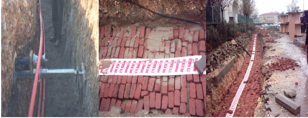
Resim 2.16: Kabloların kanala döşenmesi ve tuğlaların yerleştirilmesi
