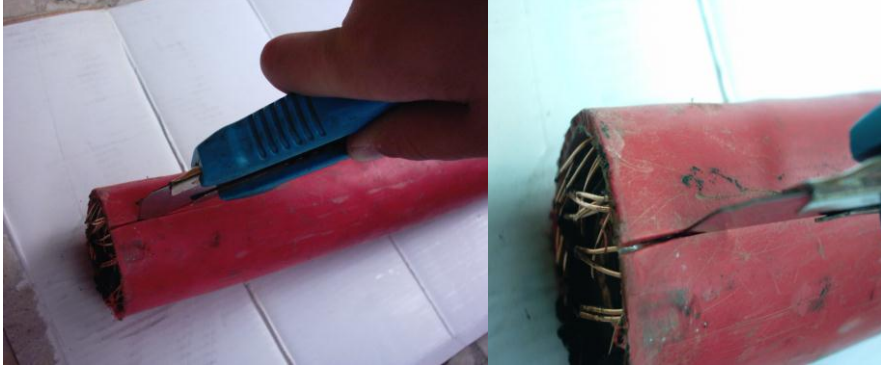
Resim 3.8: YE3SV kablunun dış kılıfının kesilmesi
