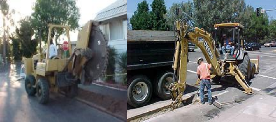
Resim 2.9: Sert zeminde kablo kanalı açma
