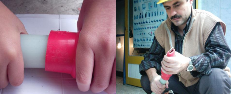
Resim 3.14: YE3SV kabloya silikon başlığın takılması
