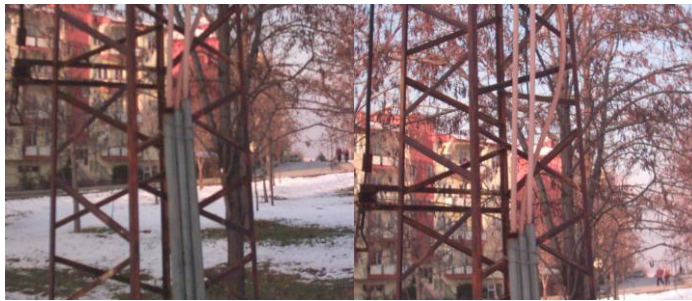
Resim 4.6: Kabloların ayrı ayrı boru içinden geçirilerek korunması
