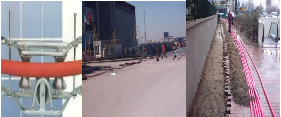
Resim 2.6: Kablo taşıyıcı ve kablo serilmesi
