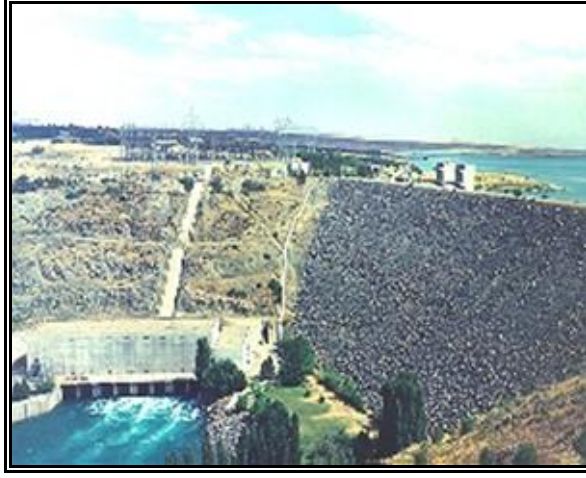
Resim 3.5: Hirfanlı barajı ve hidroelektrik santrali
