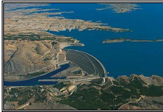
Resim 3.2: Atatürk barajı ve hidroelektrik santrali
