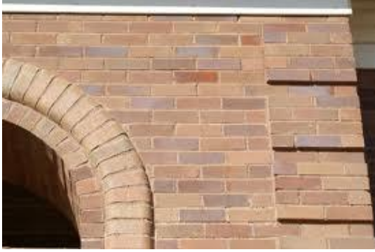
Resim 3.3: Taşıtıcı kemerli duvar
