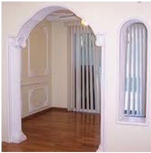
Resim 3.5: Dar açıklıklı kemerli duvar
