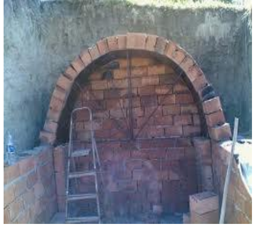
Resim 3.2: Dış mekân kemerli duvar
