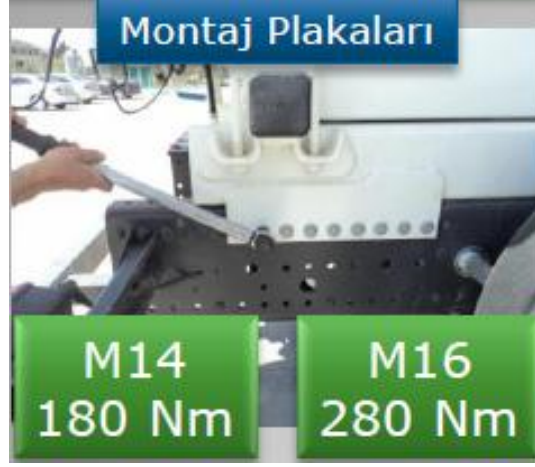
Resim 5.2: Şasi bağlantı civatalarının sıkılması
