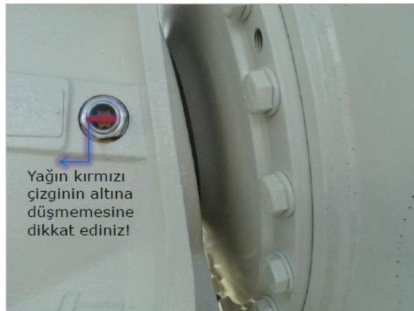
Resim 5.5: Redüktör yağ seviye kontrolü
