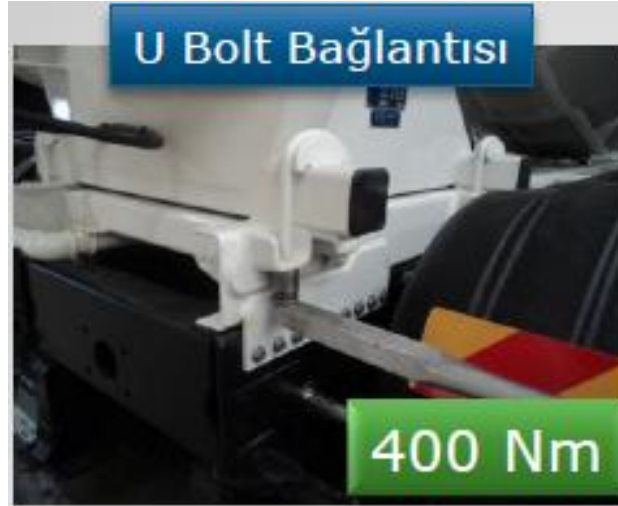
Resim 5.3: Konsol bağlantı noktalarının kontrolü
