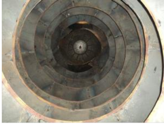
Resim 2.3: Kazan içi helisler
