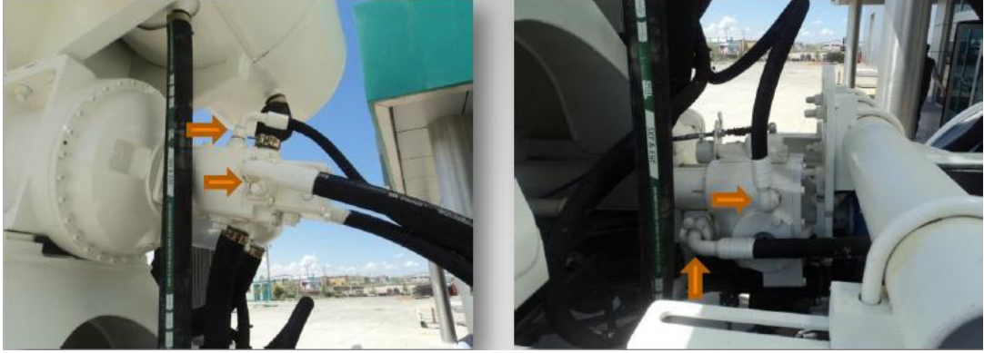
Resim 5.12: Hidrolik rekor yağ sızıntı kontrolü
