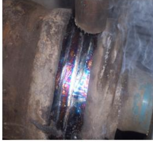
Resim 1.8: Toz altı kaynağı ile birden fazla pasoda çekilmiş kaynak
