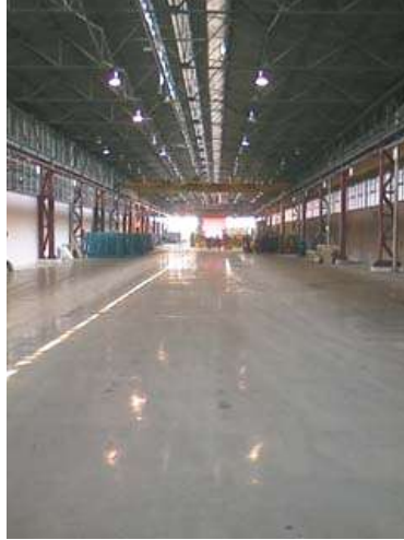
Resim 3.2: Fabrika iç sahası şap
