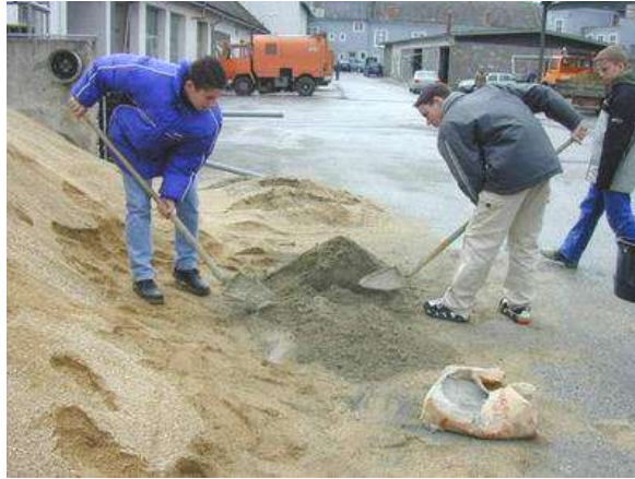
Resim 1.3: Tesviye betonu harcının el ile karıştırılması
