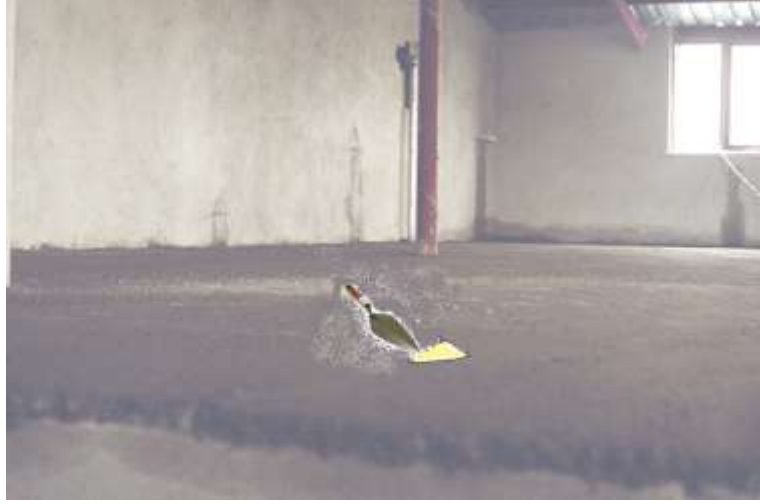
Resim 3.5: Yapışmış yabancı maddelerin kazınması
