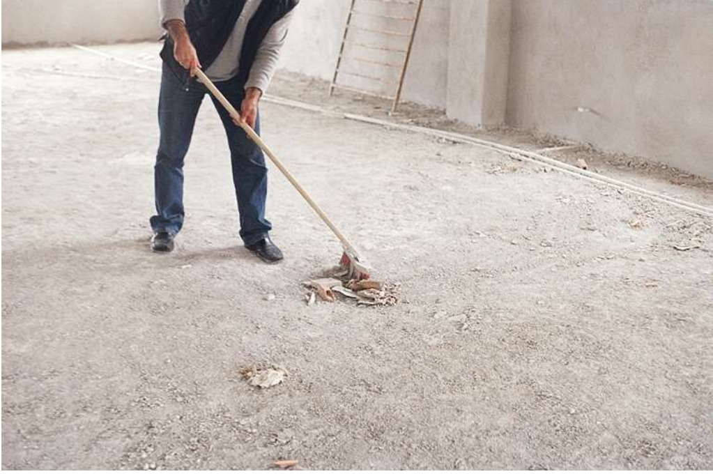
Resim 2.1: Yüzeyin temizlenmesi
