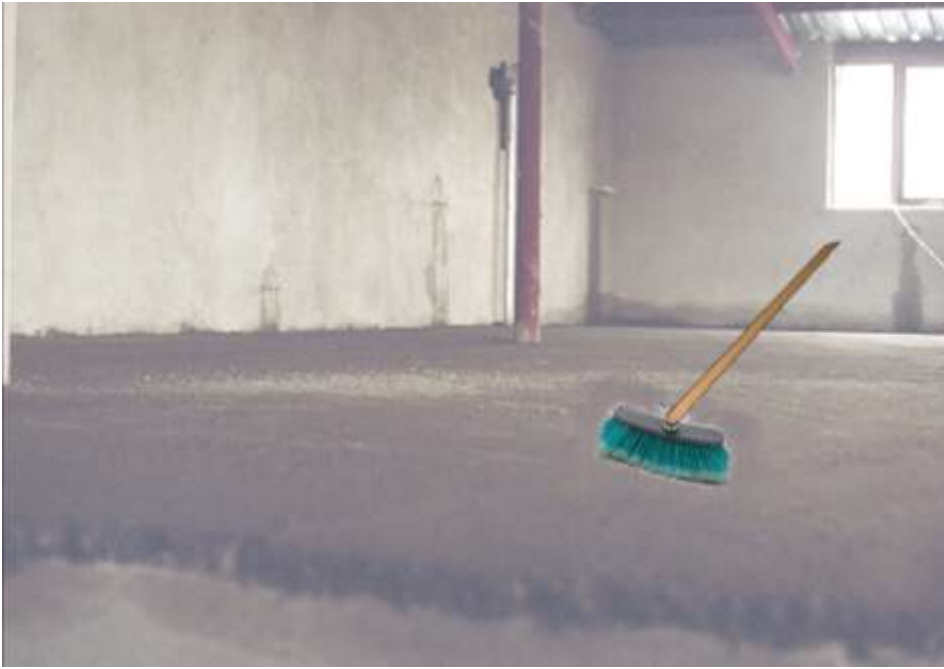
Resim 3.4: Şap dökümü için yerin temizlenmesi
