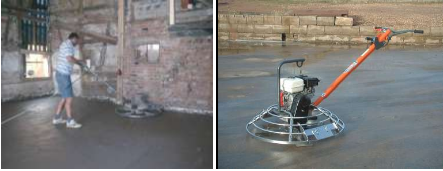
Resim 3.8: Helikopter ile zeminin düzeltilmesi
