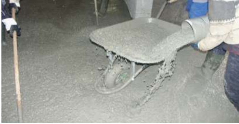
Resim 1.5: Tesviye betonu harcının araçla taşınması
