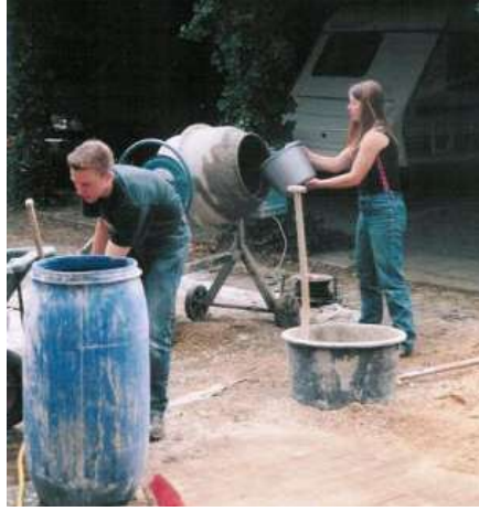
Resim 1.4: Tesviye betonu harcının betoniyer ile karıştırılması
