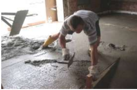
Resim 2.9: Master yapılmış yüzeyin mala ile düzeltilmesi
