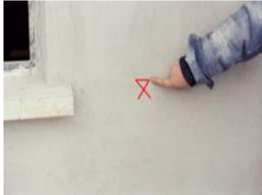
Resim 2.3: Kotun işaretlenmesi
