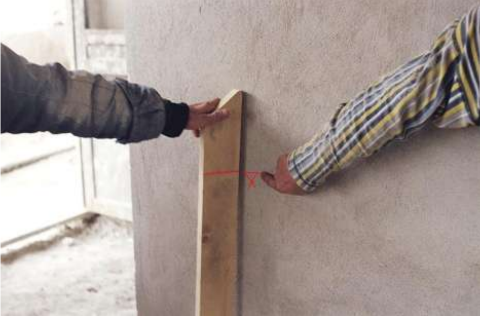
Resim 2.5: Kotun alt taraf taşınması
