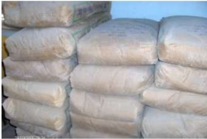
Resim 1.2: Çimento torbalarının istiflenmesi
