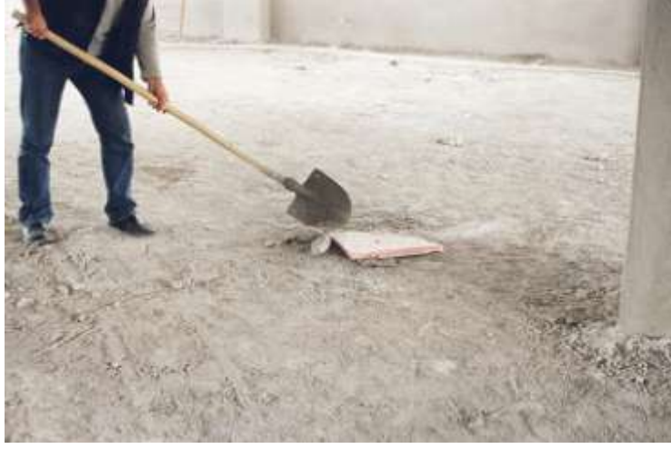
Resim 2.2: Yüzeyin yapışmış harç vb. malzemelerden temizlenmesi
