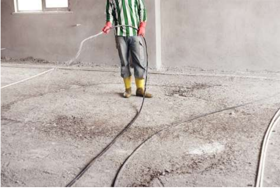
Resim 2.8: Yüzeyin sulanması
