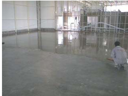
Resim 3.7: Zeminin master ile düzeltilmesi
