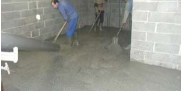
Resim 1.6: Tesviye betonu harcının boru ile taşınması
