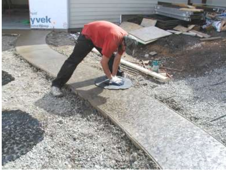
Resim 3.6: Çimento şapının üzerine desen yapılması
