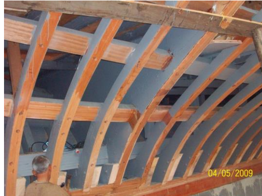
Resim 2.4: İstralya bağlantısı
