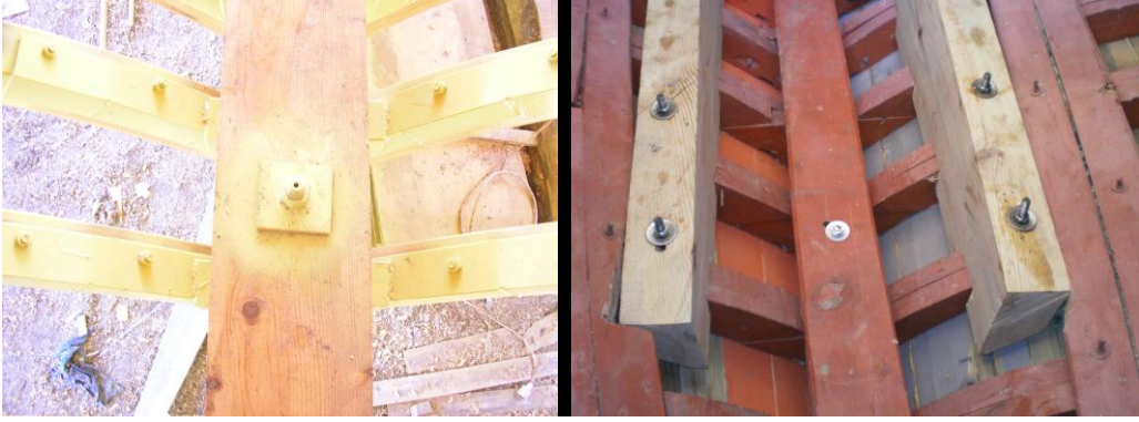
Resim 1.3: Omurga, iç omurga, posta, döşek ve döşek takviyesi bağlantısı
