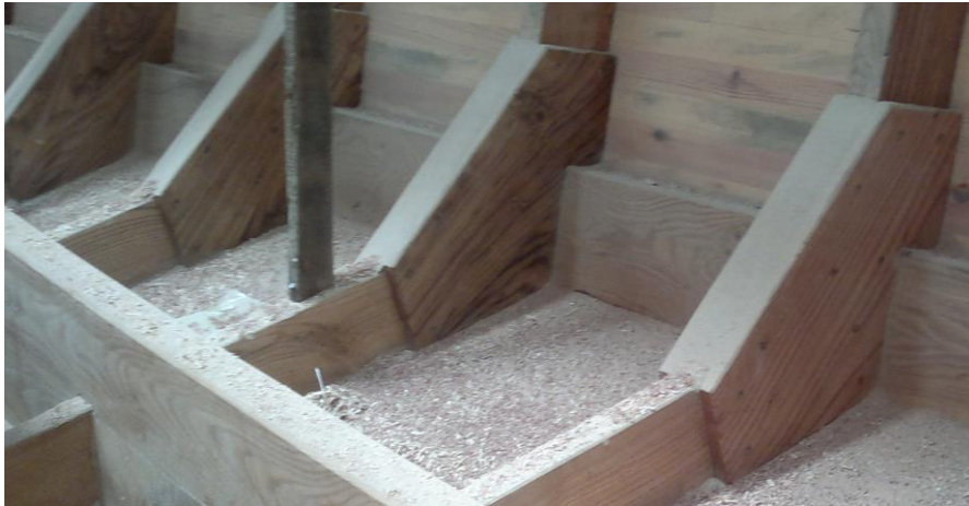
Resim 2.6: Posta-braket altında bel kertmesi
