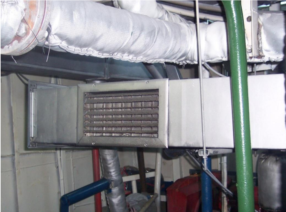
Resim 6.6: Makine dairesi iç havalandırma çıkışı
