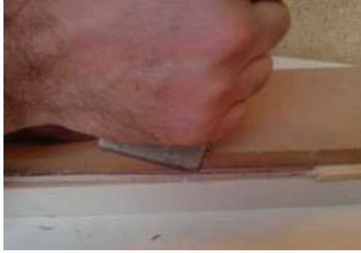
Resim 2.3: Kaplamadan master yardımıyla alıřma bıađıyla filato kesilmesi
