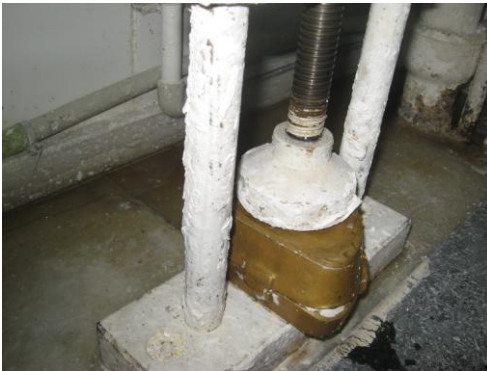
Resim 5.11: Muflanın preslenmesi
