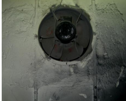
Resim 2.4: Ön ısıtmının yapıldığı odalarda havalandırma sistemi
