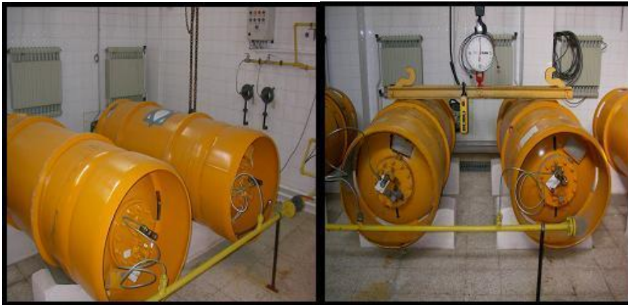
Resim 2.5: Su depolarındaki suların klorlanmasında kullanılan klor tüplerinin yatay monte edilmesi
