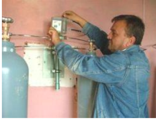
Resim 2.3: Dozaj pompasının ayarlanması
