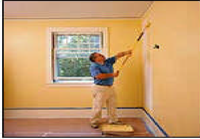
Resim 2.1: Rulo ile boya uygulama
