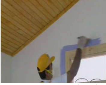
Köşe noktaların kesilmesi
