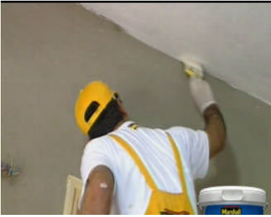
Köşe noktaların kesilmesi
