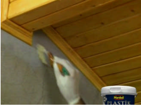
Kesme fırçasıyla köşelerin kesilmesi
