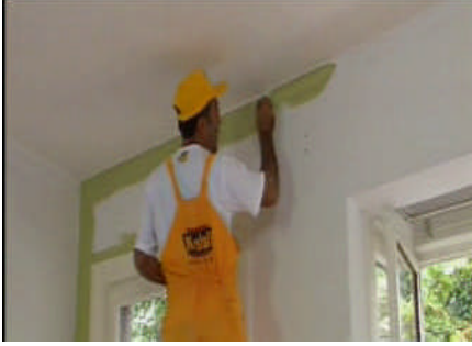
Duvar kenarlarının kesilmesi
