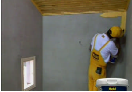
Duvar kenarlarının kesilmesi
