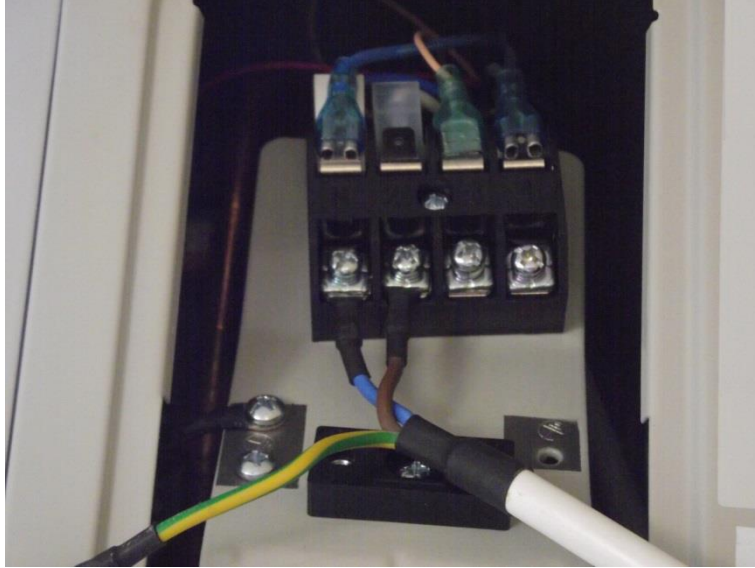
Resim 5.2: Dış ünite besleme ve sinyal kablolarının bağlanması
