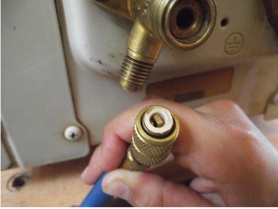
Resim 6.5: Üç yollu vanaya iğneli hortum ucunun takılması
