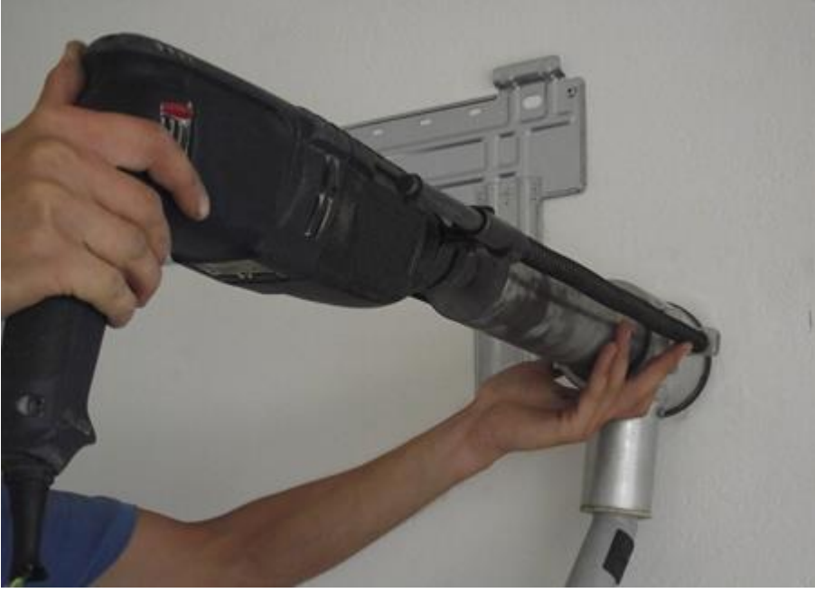
Resim 2.8: Ara boru bağlantı delik yerinin panç kullanılarak delinmesi
