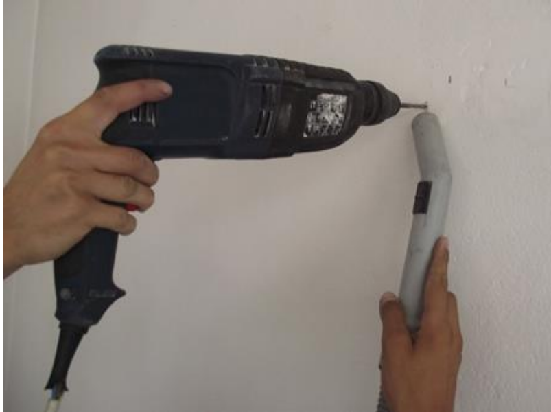
Resim 2.5: Matkap ve elektrik süpürgesi kullanılarak delik yerlerinin delinmesi.
