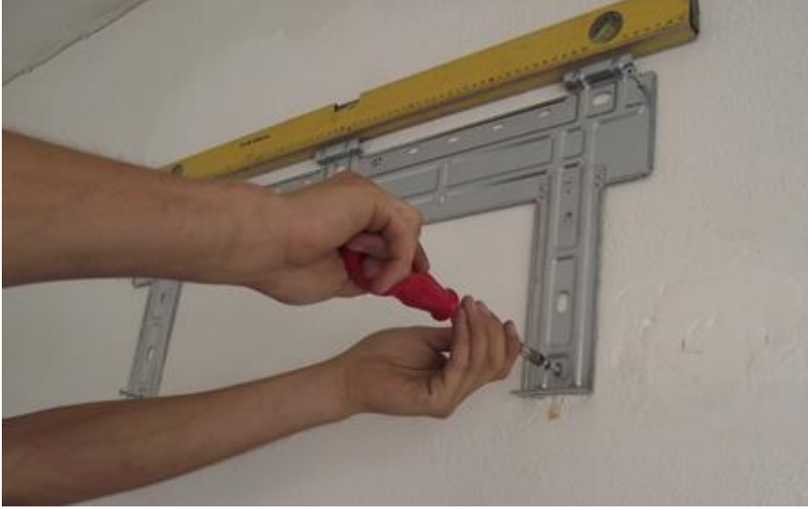
Resim 2.6: İç ünite montaj plakasının montajı
