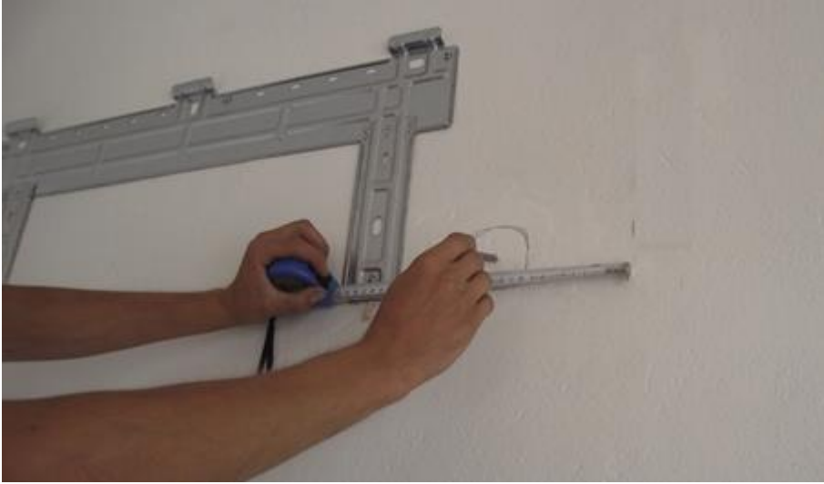
Resim 2.7: Ara boru bağlantı delik yerinin işaretlenmesi
