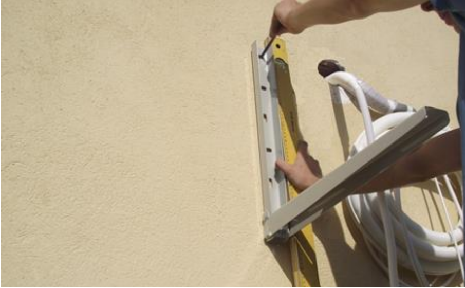
Resim3.3:Dış ünite ayağının montaj yerinin işaretlenmesi
