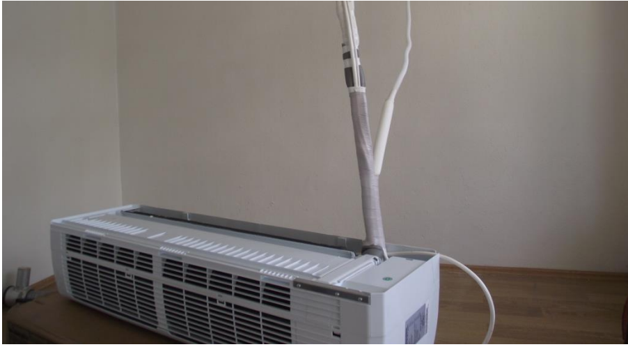
Resim 4.9: Boruların iç üniteye montajının tamamlanması
