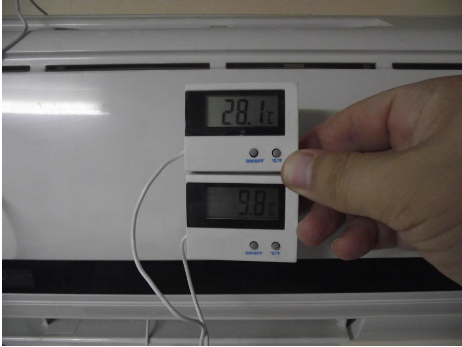
Resim 8.2: Soğutma modunda iç ünite hava emiş ve üfleme sıcaklıkları
