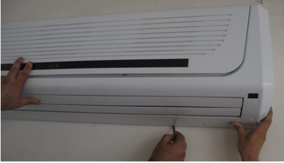
Resim 2.2: İ ünite montaj yerinin işaretlenmesi
