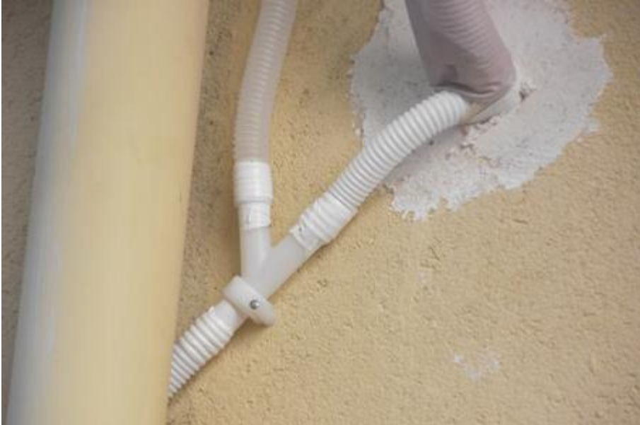
Resim 3.11: İç ve dış ünite drenaj hortumlarının Y ek parçasıyla birleştirilmesi
