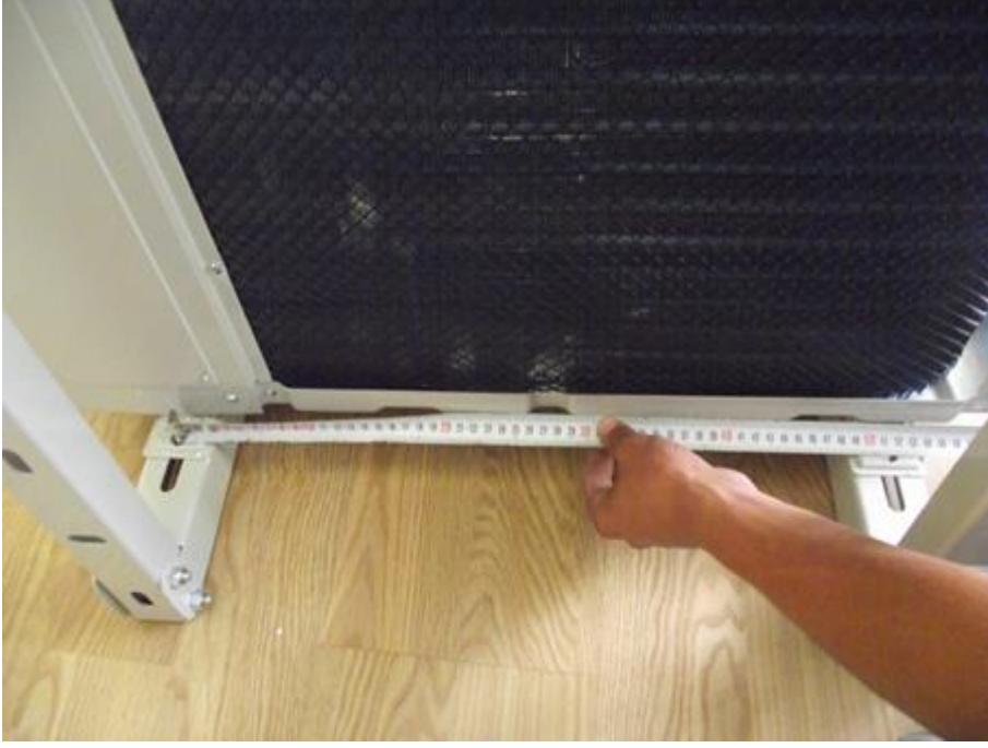
Resim3.2:Dış ünite ayaklar arası boşluğunun ölçülmesi
