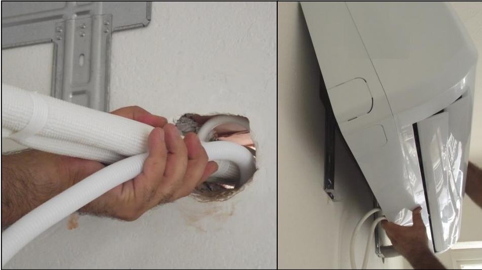
Resim 4.10: Boruların dıř ünite tarafına iletilmesi, iç ünitenin plakaya oturtulması
