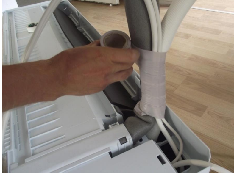
Resim 4.7: Boruların dekoratif bantla sarılması
