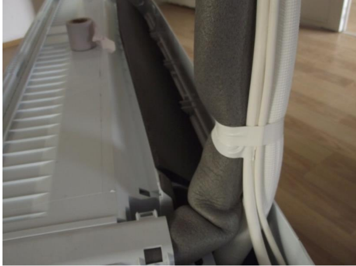
Resim 4.6: Boru çıkış yönünün ayarlanması
