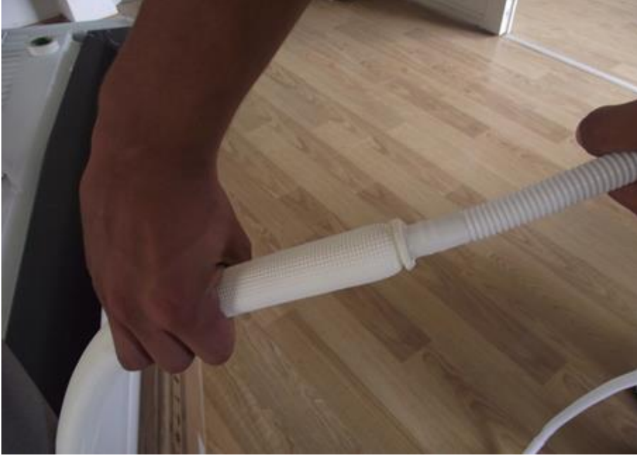
Resim 2.13: İ ünite drenaj borusuna ek yapma
