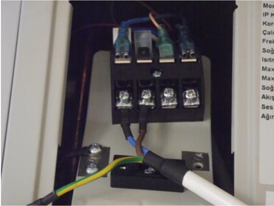
Resim3.7:Dış ünite sinyal ve enerji kablo bağlantılarının yapılması
