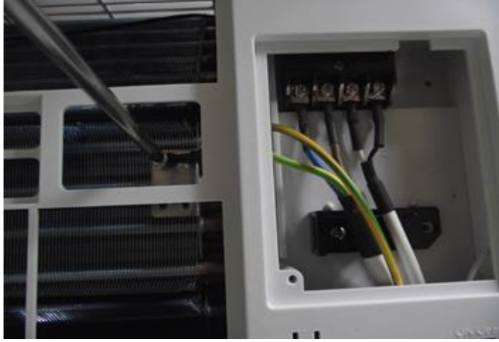
Resim 2.11: İç ünite Sinyal ve enerji kablo bağlantısı
