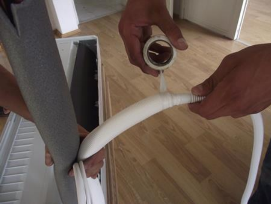
Resim 2.14: İ ünite drenaj borusu montajı
