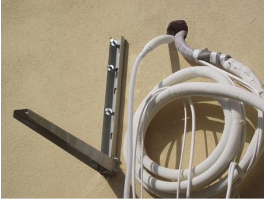
Resim3.4:Dış ünite ayağının montajı
