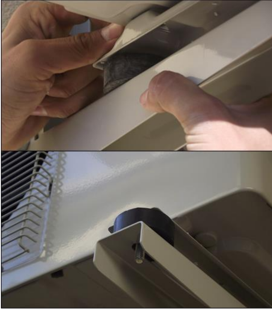
Resim3.6:Dış ünite ayaklar üzerine yerleştirilmesi
