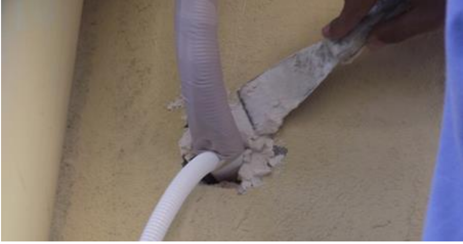
Resim 3.10: Boru çıkış deliklerinin kapatılması
