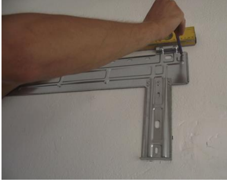
Resim 2.4: İç ünite montaj plakasının montaj deliklerinin işaretlenmesi
