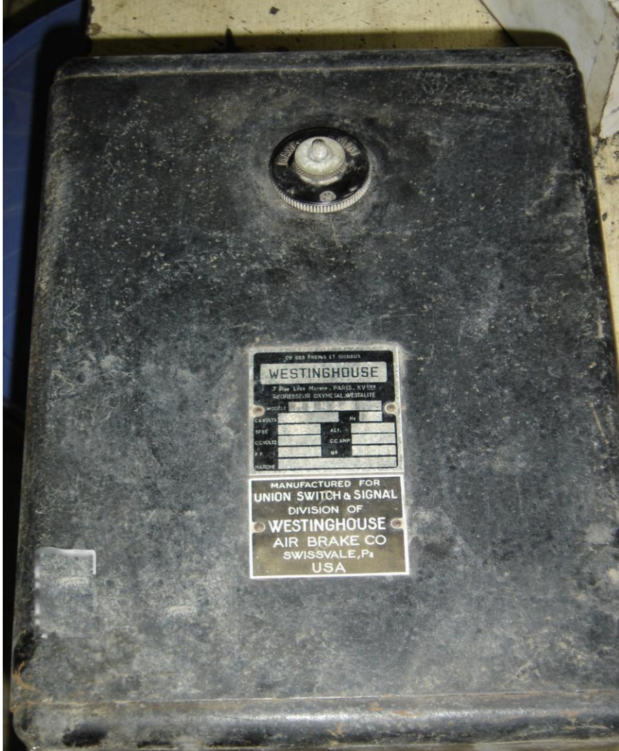
Şekil 2.4: TCDD Eskişehir katenerinde kullanılan Amerika yapımı bir redresör
