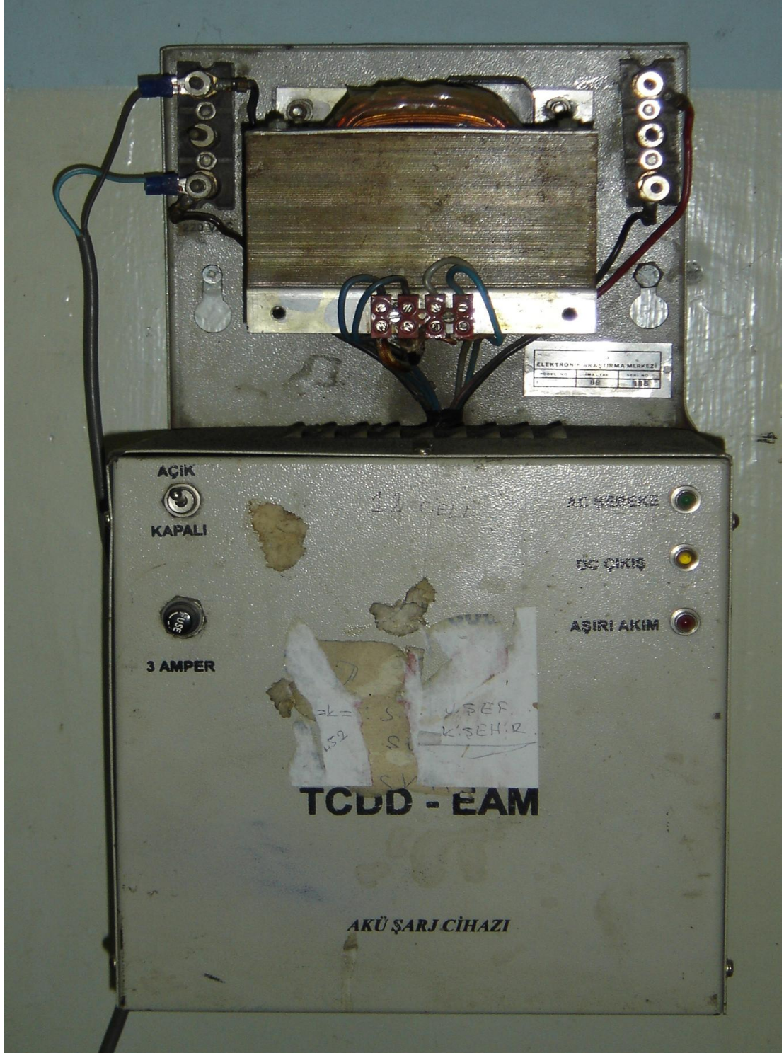
Şekil 2.9: TCDD Eskişehir katenerinde kullanılan bir akü şarj cihazı
