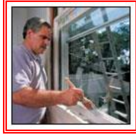
Resim 1.5: Astarı fırça ile uygulama
