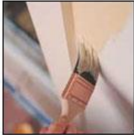
Resim.2.2: Kestirme fırça uygulaması
