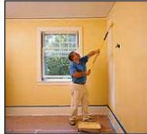
Resim.2.3: Rulo ile boya uygulama
