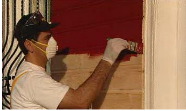
Resim.1.6: Fırça ile sentetik boya uygulama
