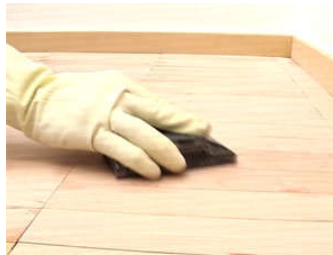
Resim 1.4: Ahşap yüzey zımparalama
