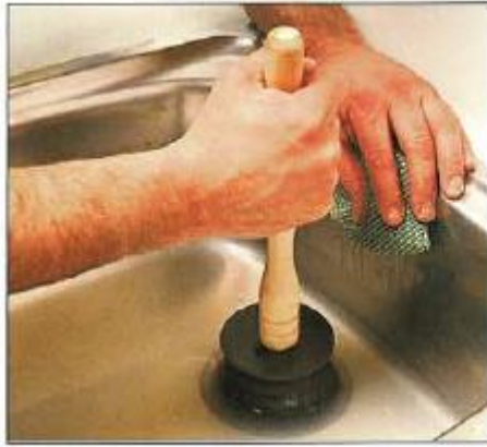
Resim2.4:Sifonun pompa ile açılmasıŞekil2.2:Sifonun açılması
