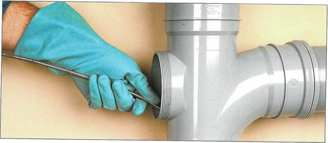
Resim2.5:Atık su tesisatının temizleme kapağında temizlenmesi
