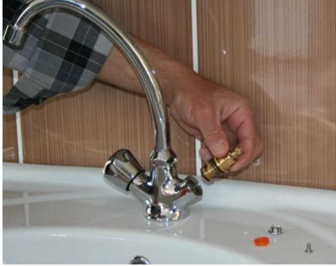
Resim2.1: Arızalı bir bataryada salmastra grubunun sökülmesi
