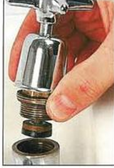
Resim2.2:Mekanik Parça Deęiřimi
