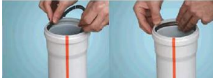
Resim2.7:Conta takılması ve kontrolü
