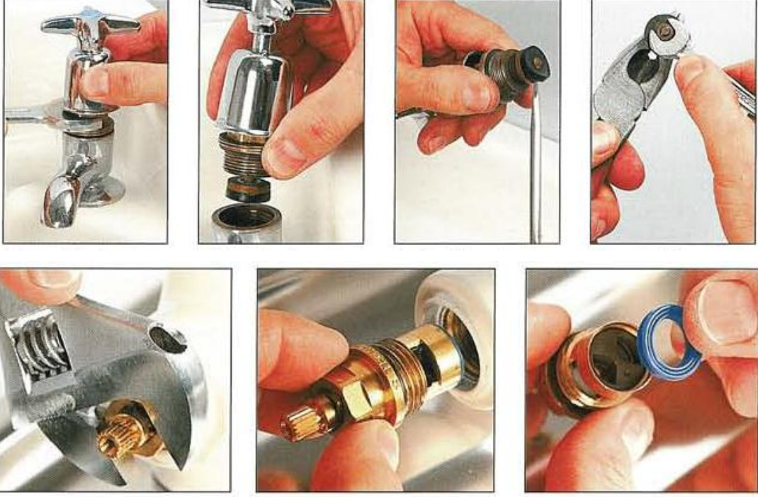
Resim2.10: Banyo bataryası parçaları
