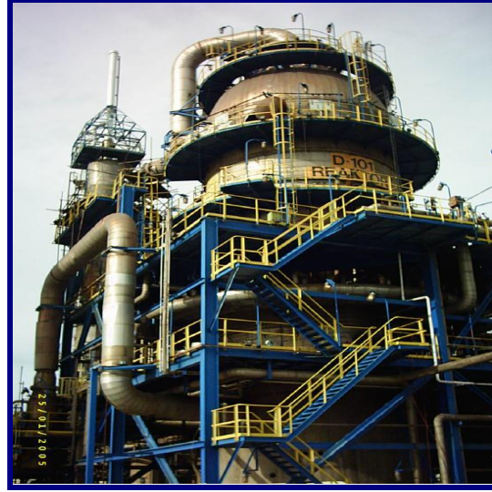
Resim 1.3: Akışkan yataklı reaktör
