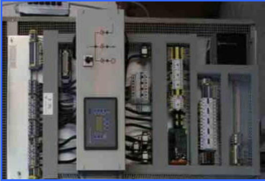
Resim 1.3: DMU aydınlatma kontrol paneli
