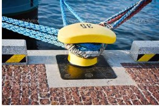
Resim 1.9: Rıhtımdaki palamarcının halatları doğru bir şekilde taktığının kontrol edilmesi
