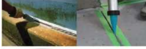
Resim 2.2: Dolgu olarak kullanılan elastik polimerler
