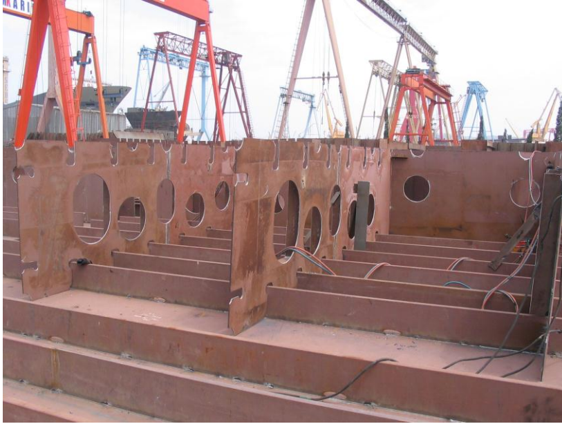
Resim 1.3: Tülaniler ve dolu döşeklerin panel üzerinde kaynatılışii
