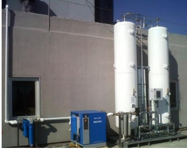
Resim 1.2: Merkezi sistem oksijen jeneratörü ve depo tankları
