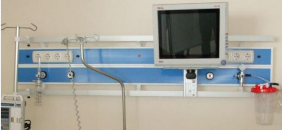
Resim 1.3: Hasta başı oksijen sistemi
