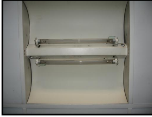
Resim 9.1: Tavana monte edilmiş ultraviyole (UV) lambası
