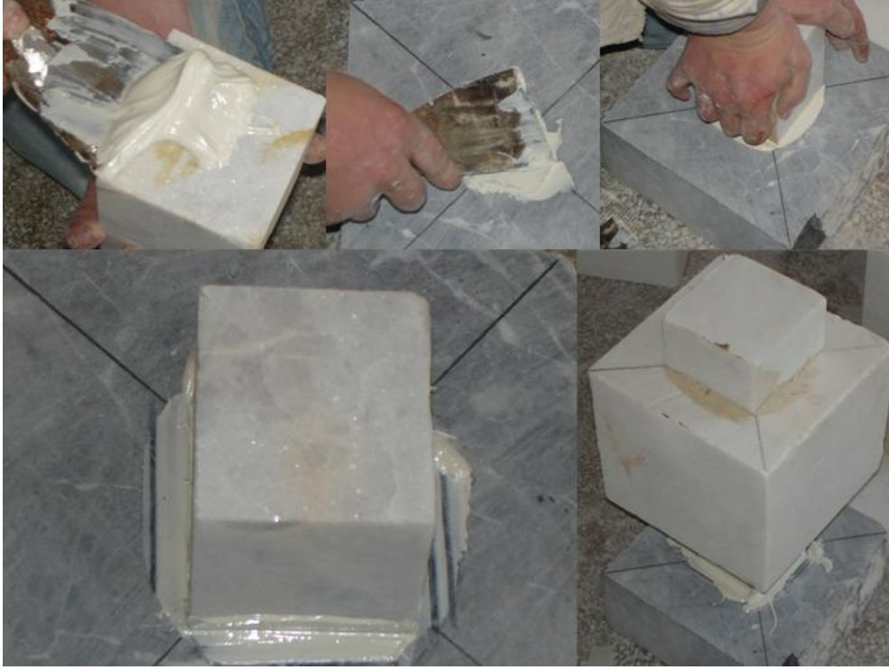
Resim 2.4: Takozun akemi ile yapıştırılması
