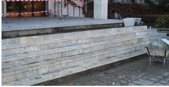
Resim 2.6: Doğal yapıştırıcılarla yapıştırma
