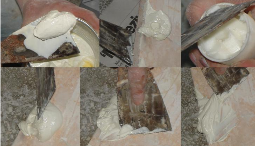
Resim 2.2: Akeminin hazırlanışı
