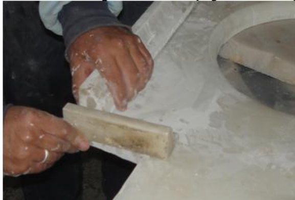
Resim 2.5: Mutfak tezgâhının çitalarının yapıştırılması
