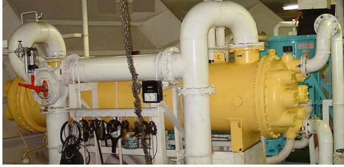
Resim 2.1: Yağlama yağı kuleri giriş ve çıkışı
