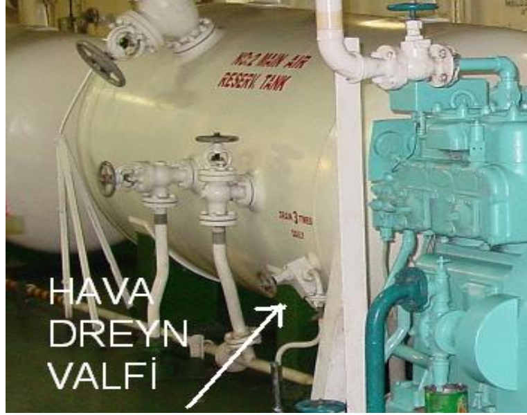
Resim 1.1: Hava tankı üzerindeki dreyn valfi
