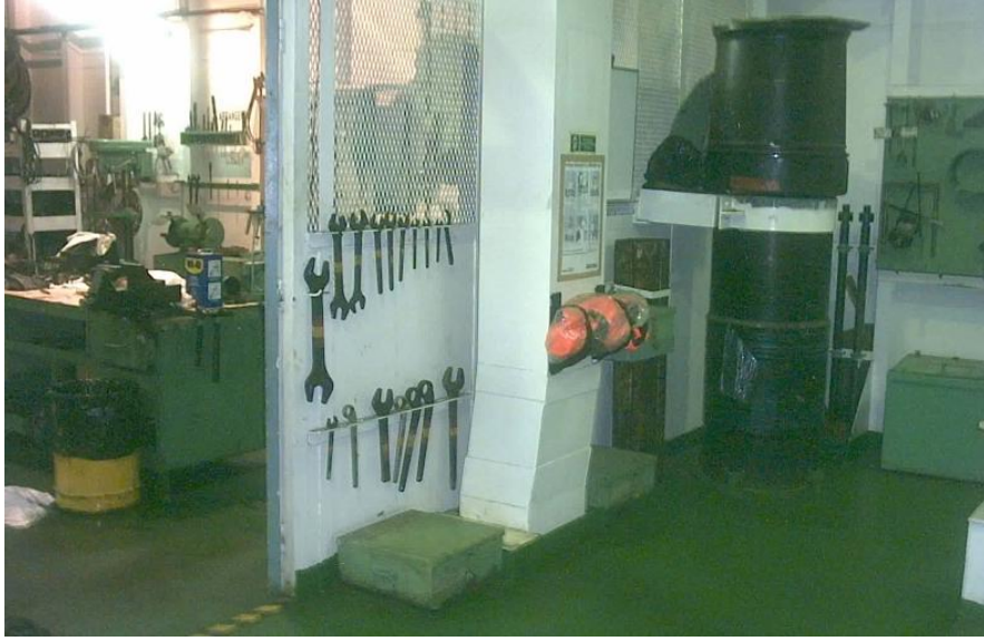
Resim 4.2: Makine dairesinde bulunan takım ve malzemelerin yerleri
