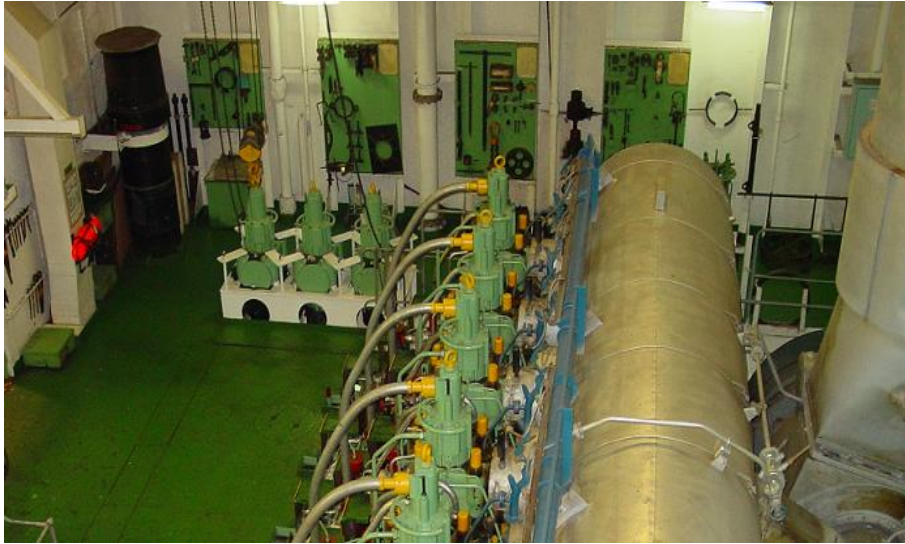
Resim 4.3: Makine dairesinde bulunan takım ve malzemelerin genel görünümü
