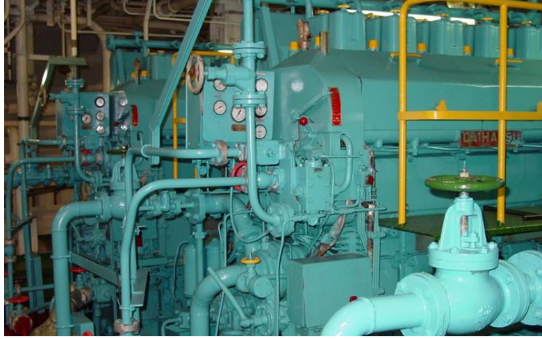
Resim 1.2: Ana makine sistemlerindeki sırayla açılacak valflar
