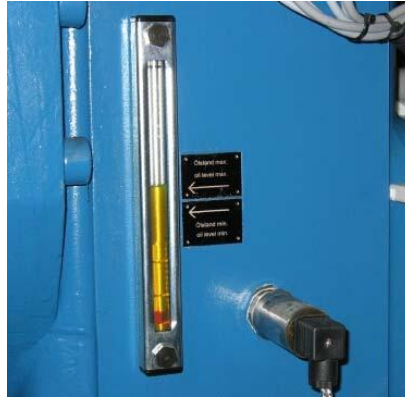
Resim 6.1 Yağ seviyesi kontrolü için kullanılan kontrol camı
