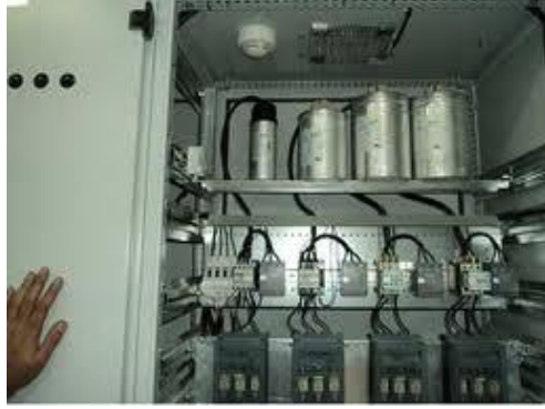
Resim4.6: Dağıtım panosunda kullanılan duman sensörü
