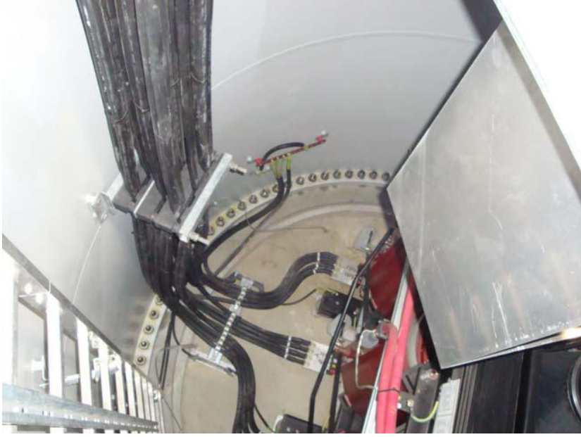
Resim 8.1 Yukarıdan bakıldığında trafo bölümü
