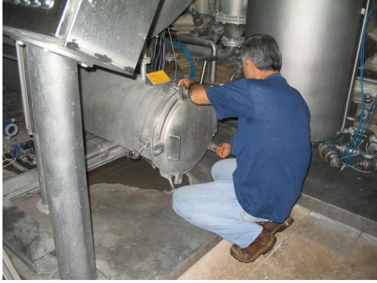
Resim 1.7: Makine çalıştırılmadan önce filtrenin kontrol edilmesi
