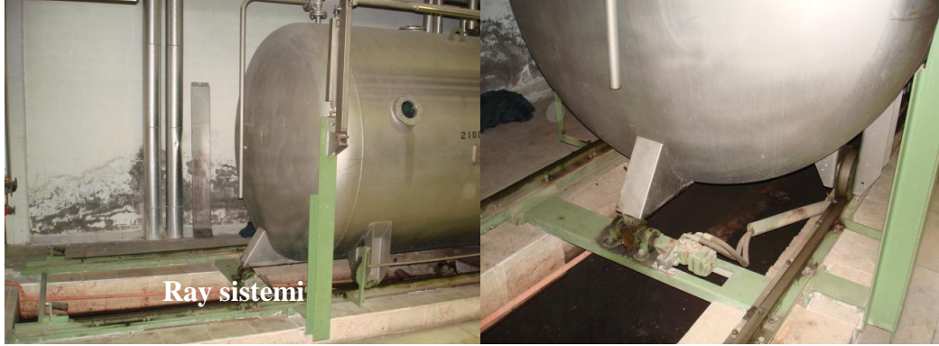
Resim 2. 11: Yatay otoklavı hareket ettiren ray sistemi
