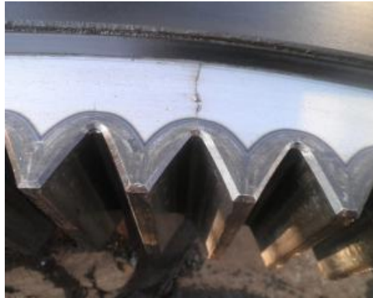
Resim 5 .1: Çatlamış bir kule dönüş dişlisi
