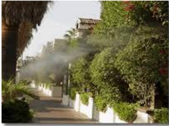
Resim 1.17: Evaporatif Sistem
