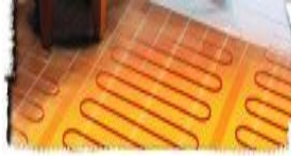
Resim 1.6: Zeminden elektrikli ısıtma
