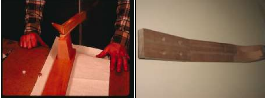
Resim1.10: Sapa takozun yapıştırılması
