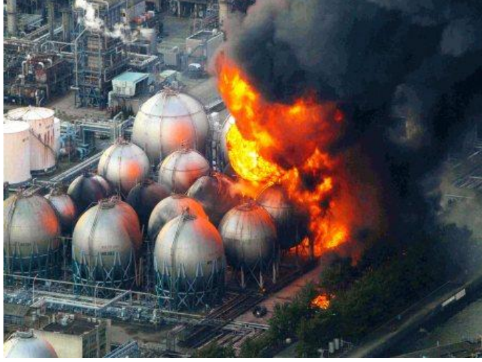
Resim 1.1: Fukuşima nükleer santralinde yangın
