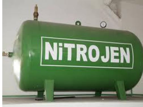
Resim 1.3: Nitrojen gaz tankı
