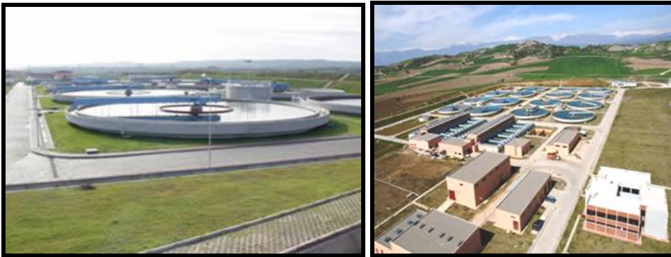
Resim 2.1: Ham su arıtım tesisi
