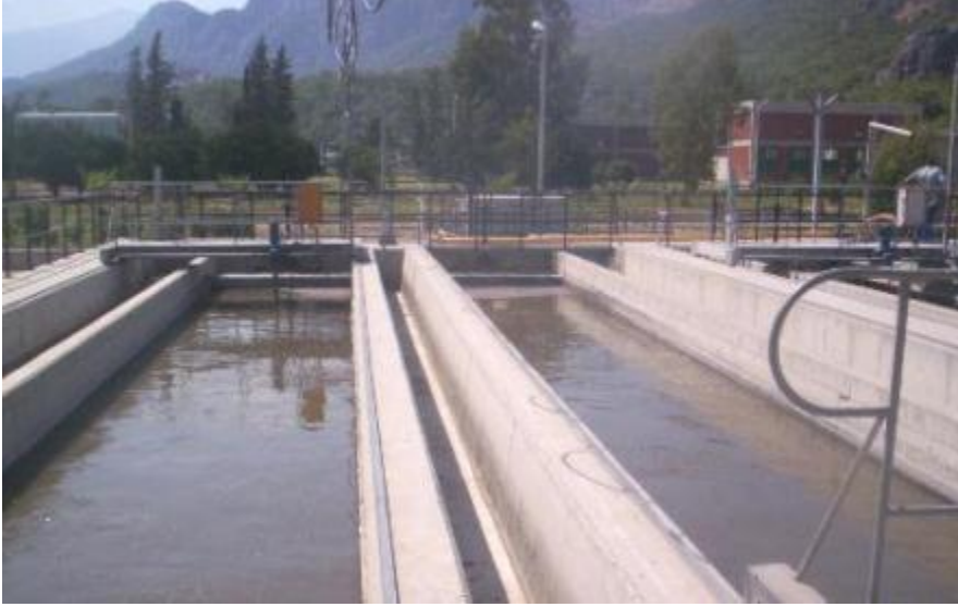
Resim 2.7: Kum ve yağ tutucuların bir arada uygulanması
