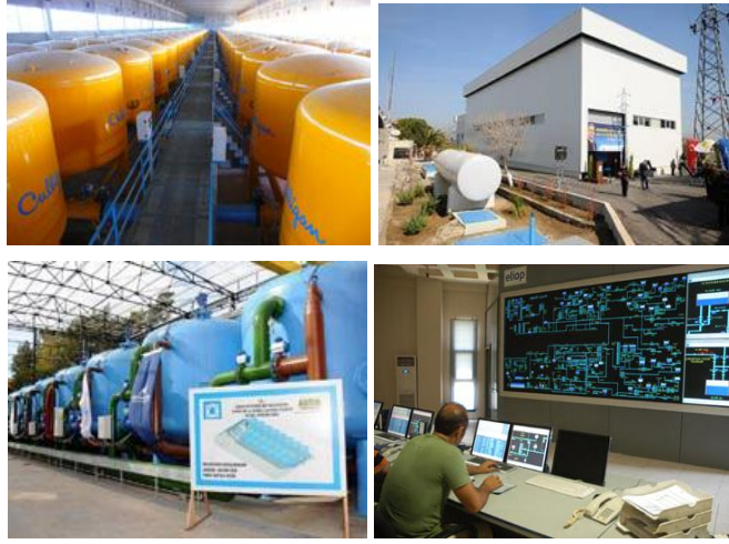
Resim 1.7: İçme suyu arıtma tesisleri ve kumanda merkezi
