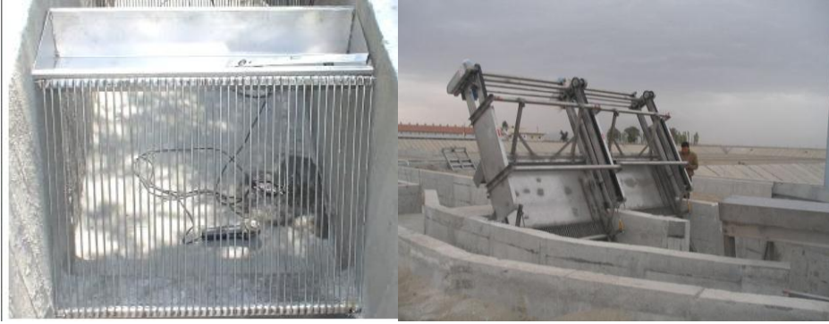
Resim 2.3: Manuel temizlemeli kaba ve ince ızgaralar
