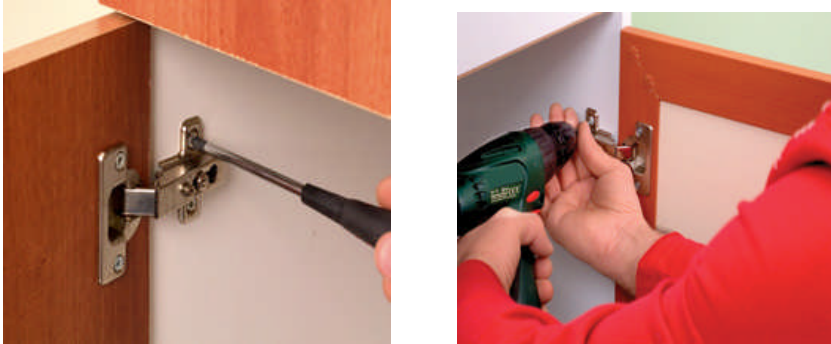
Resim 2.20: Kapağın gövdeye montajı
