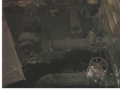
Resim 2.4: Suyu söndürme istasyonuna basan pompa
