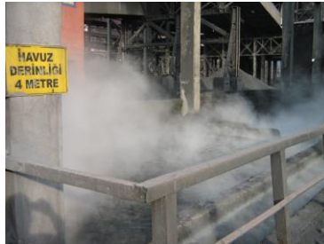
Resim 2.7: Su temizleme ve soğutma havuzu
